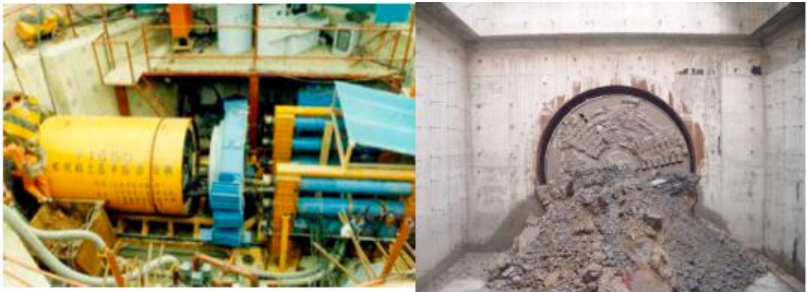
机械顶管施工法
