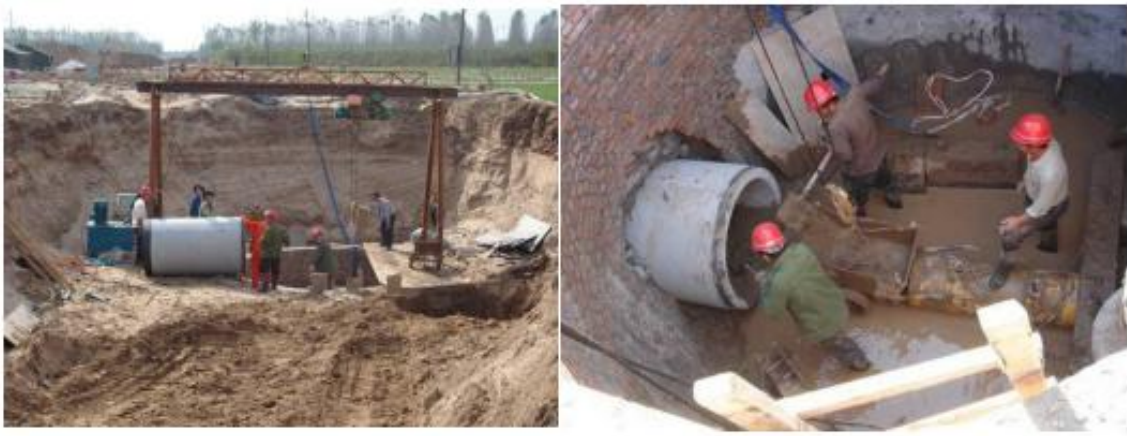
人工顶管施工法
