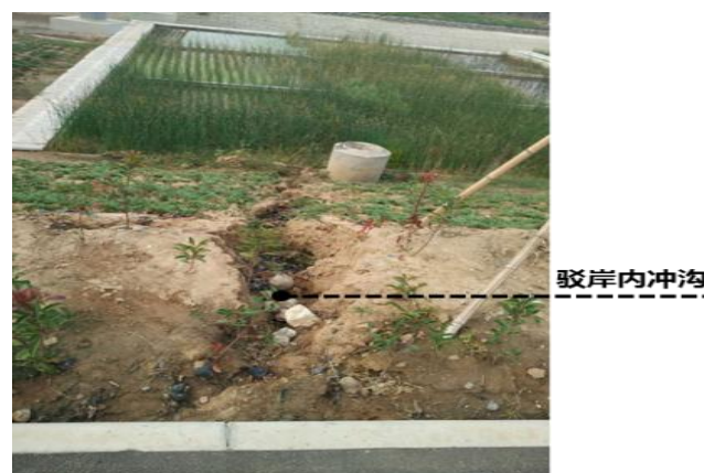
图7.128 清潁河河岸冲蚀现状图
